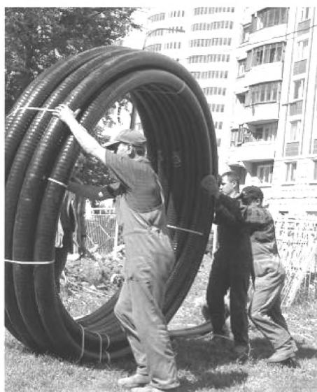
Рисунок 4.3 – Размотка ГПИ-труб, поставляемых в бухтах
